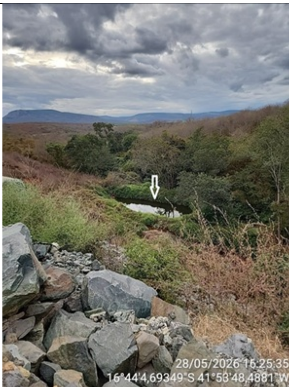
Figura 17. Acumulação hídrica a jusante da pilha 2 ("SUMP") em ponto de deságue de curso d'água intermitente aterrado pela pilha.
