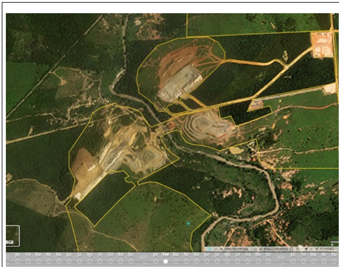
Figura 3. Imagem aérea de fevereiro de 2023 da plataforma PF-SCCON, demonstrando a aberturas das cavas e a formação das pilhas.
